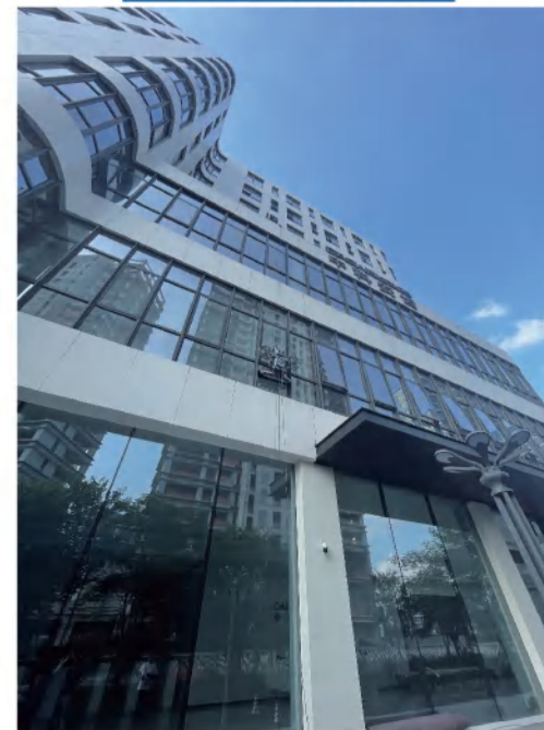
Podium curtain wall
